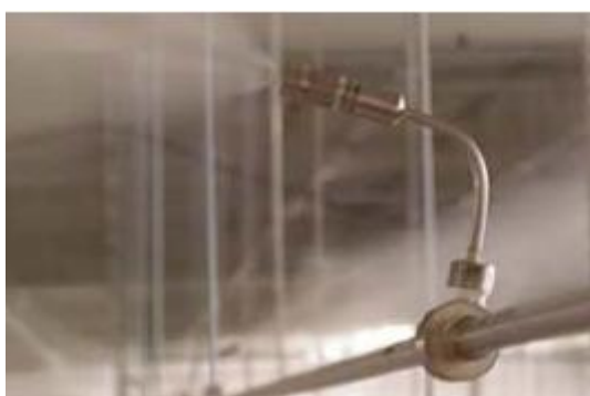
Рисунок 37. Воздушно-водная система орошения
