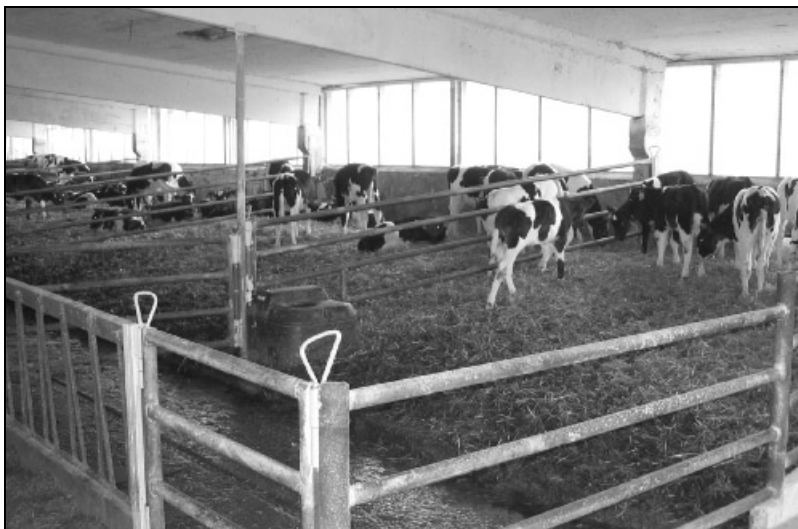
Рис. 7. Секция с наклонным (самоочищающимся) полом
